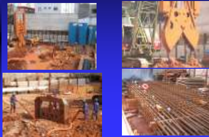
Estaca Barrete / Parede Diafragma
