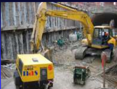
Estações e perfis metálicos atirantados
