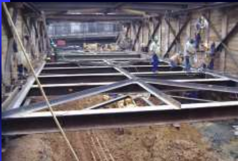
Perfis metálicos escorados e pranchada de madeira
