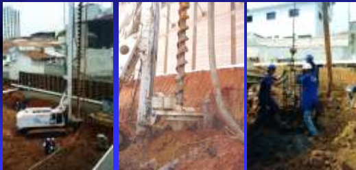
Estaca Hélice Contínua
