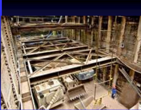
Perfis metálicos escorados e pranchada de madeira
