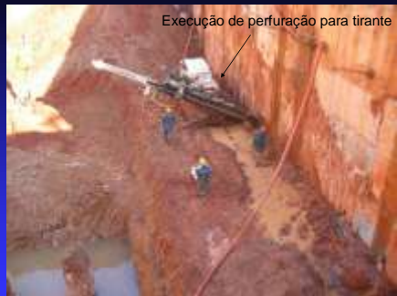
Parede diafragma atirantada
