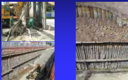
Estaca Hélice Contínua Secante
