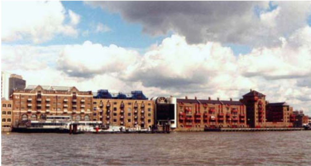
Figura 2: Renovação urbana dos armazéns de St. Katherine's Dock. Foto: autor, 1994.
